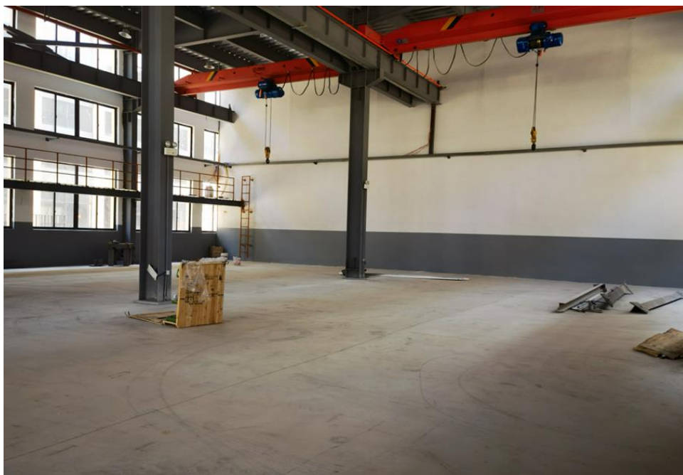
图2-20 温岭市康诺机械有限公司现场照片
