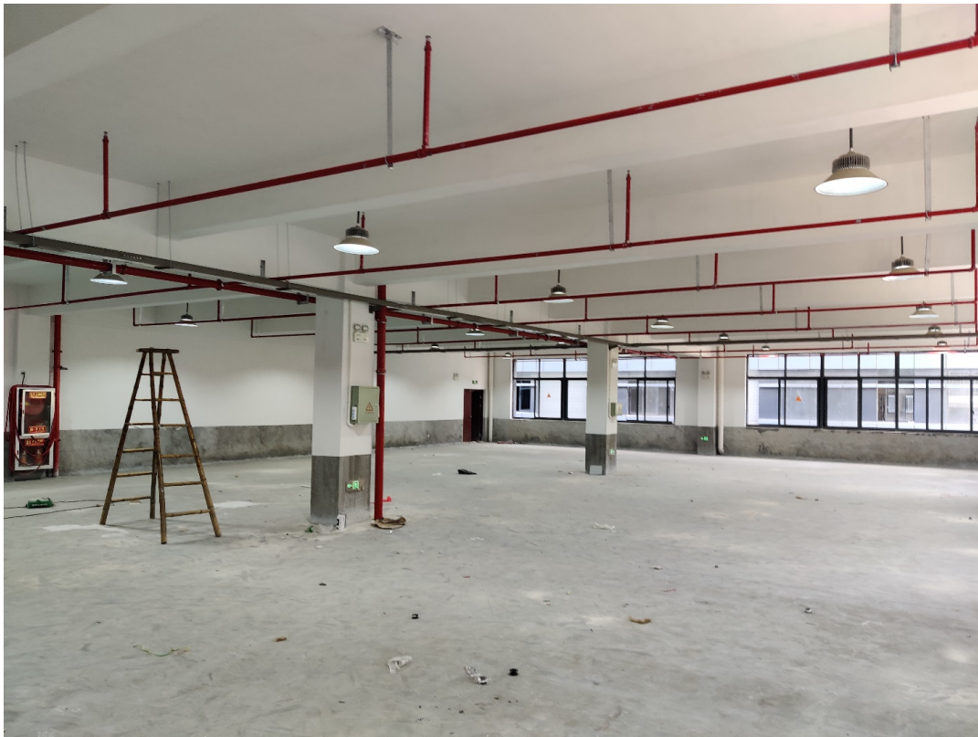
图 2-3 厂房现状照片
