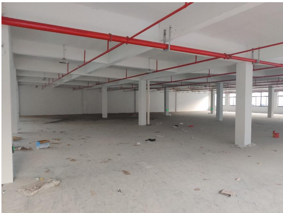
图 2-3 厂房现状照片
