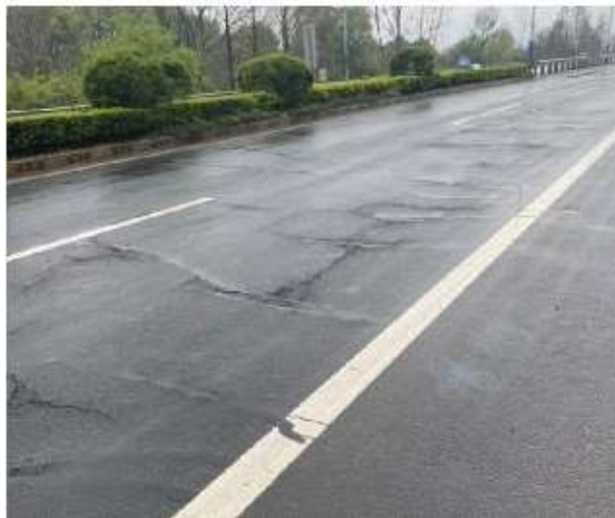
图 3-3 现状道路路面
