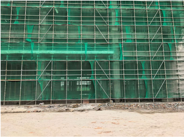
主厂区现场照片
